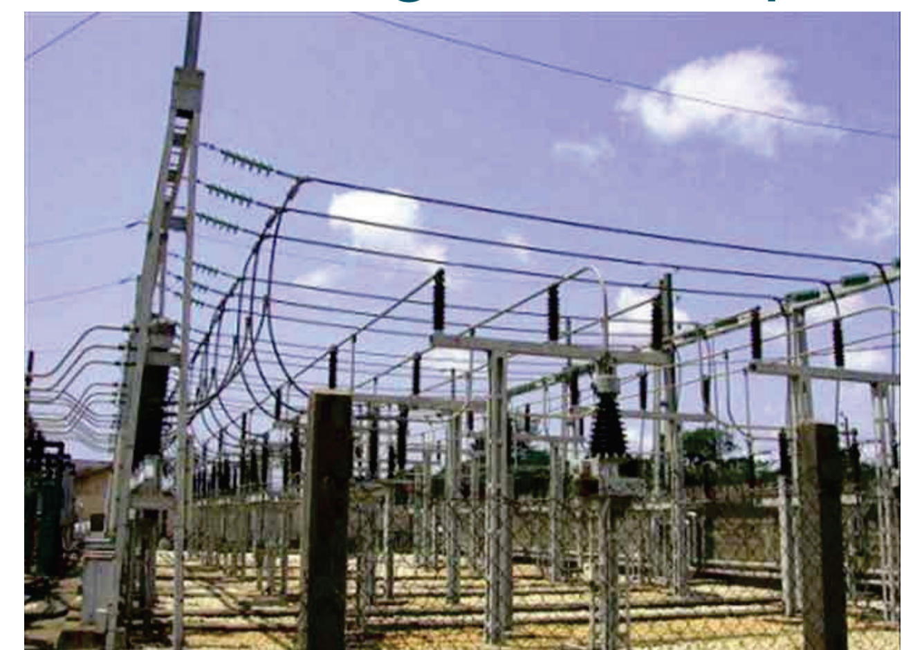
Sécurité et gestion de l'énergie électrique
